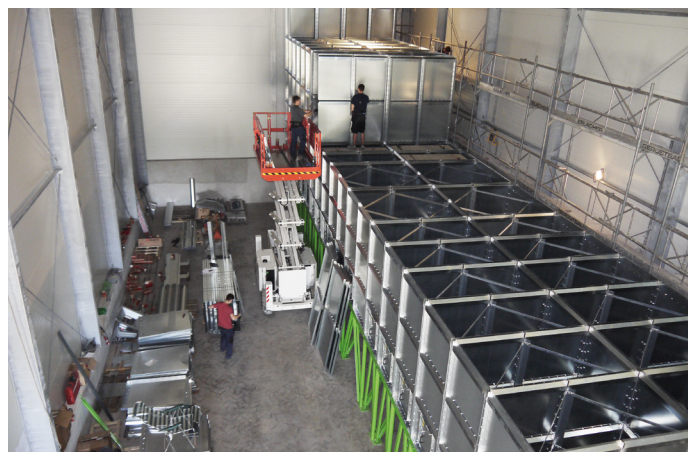
Trichtersilo Aufbau
