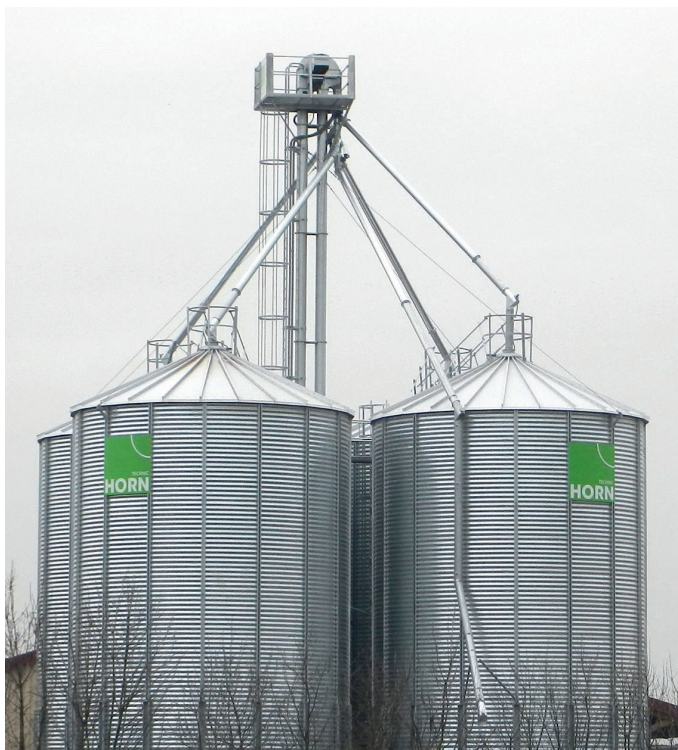
Außensilo mit Podest
